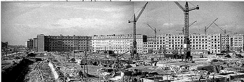
Widok os. Centrum D-31 w budowie
