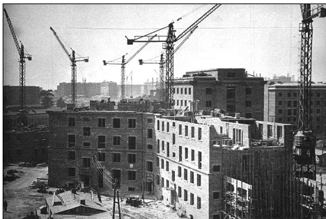
Żurawie dyktują tempo budowy
