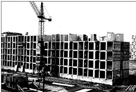
Blok ze ścianami żużlobetonowymi oś. D-1
